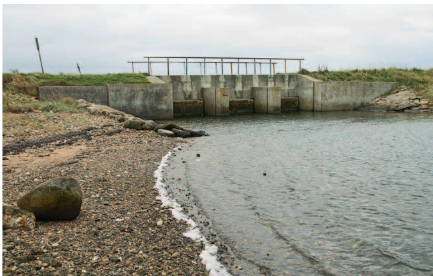
Der er tre sluseporte i Hygum Nor-slusen fra 1963, men den skal også udlede nedbør og drænvand fra flere tusinder af hektarer lavtliggende agerjord. Billedet er taget fra fjordsiden.
